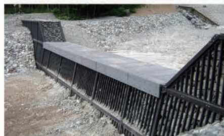
▲北陸地方整備局松本砂防事務所 八衛門沢床固工(長野県)
