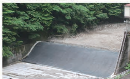
▲近畿地方整備局紀ノ川ダム統合管理事務所 川原樋川取水堰(奈良県)
