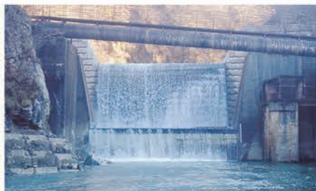
▲北陸地方整備局金沢河川国道事務所 中ノ川第一砂防堰堤(石川県)
