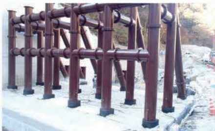
▲中部地方整備局多治見砂防国道事務所 越百川第3号砂防堰堤(長野県)
