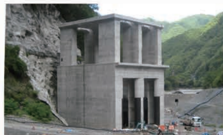
▲中部地方整備局天竜川ダム統合管理事務所 小渋ダムバイパストンネル(長野県)
