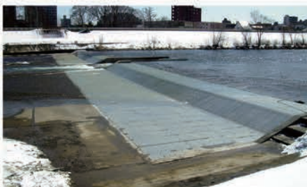
▲北海道開発局札幌開発建設部札幌河川事務所 豊平川5号床止護床工(北海道)
