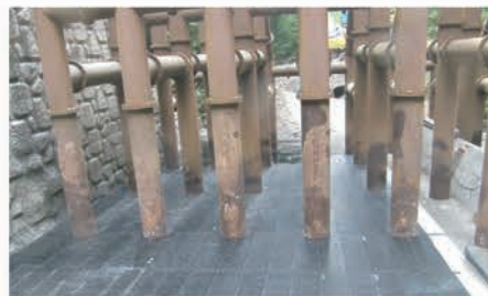
▲北陸地方整備局松本砂防事務所 波田黒川第3砂防堰堤(長野県)
