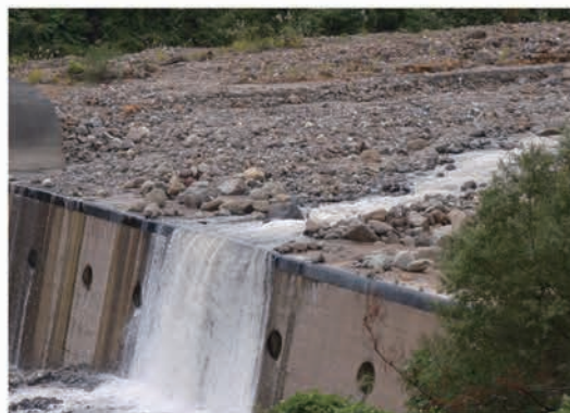
▲ラバースチール設置あり(経過年数18年) (位置：左記砂防堰堤の上流) 下流のコンクリート製砂防堰堤が、10年で最大約10m の摩耗を受ける環境下でもラバースチールは健全に 機能しています。
