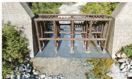
▲北陸地方整備局松本砂防事務所 南股第4号砂防堰堤(長野県)
