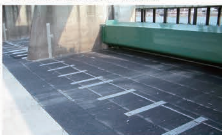
▲東海農政局 新濃尾農地防災事業所犬山頭首工(愛知県)
