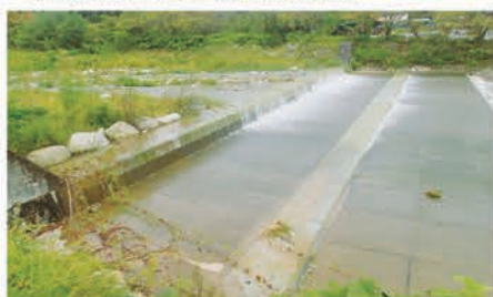
▲中部地方整備局天竜川上流河川事務所 片桐松川床固工群(長野県)
