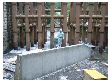
写真-5 仮設工(半川締め切り)
