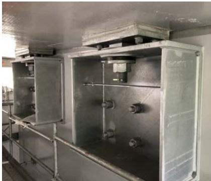
桁下型（RC 中空床版ロッカー脚設置）
