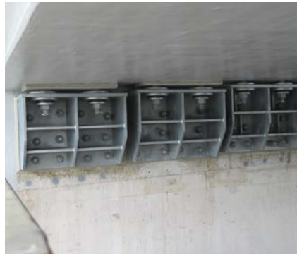
桁下型（鋼製架台 2 本設置）
