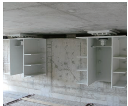
桁下型（Al・Mg 溶射、W ナット仕様）
