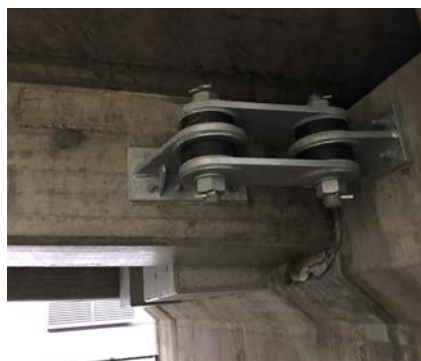
連結型（RC 桁－変位制限構造）
