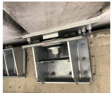
桁下型（PC ホール桁設置）
