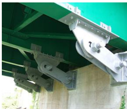
連結型（上部－下部連結、落橋防止）
