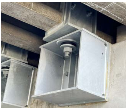
桁下型（RC-T 桁設置）
