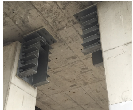
桁下型（直角方向設置）
