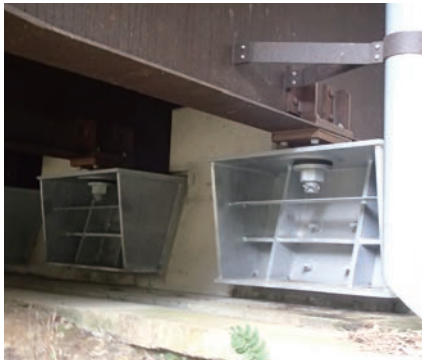
桁下型（板桁）
