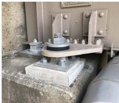
応用型（羽根連結板－PL 架台）
