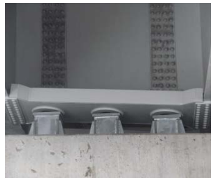
応用型（横梁－鋼製架台）
