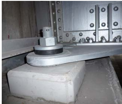
基本型（羽根連結－根巻コンクリート）
