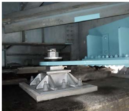
応用型（板桁橋羽根連結板－鋼製架台）
