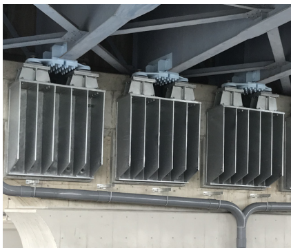
応用型（羽根連結板－橋座前面鋼製架台）
