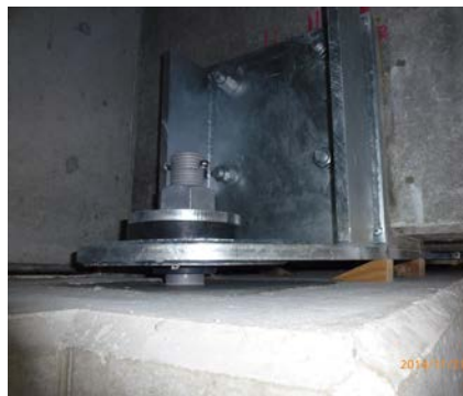
基本型（RC-T 桁 縁端拡幅部設置）
