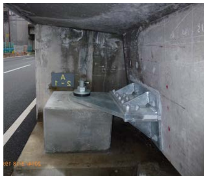
基本型（RC 中空側面設置）
