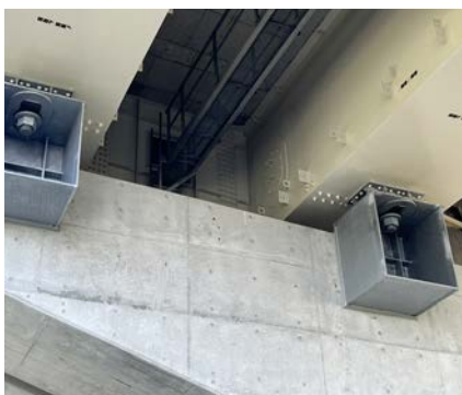
桁下型（箱桁）
