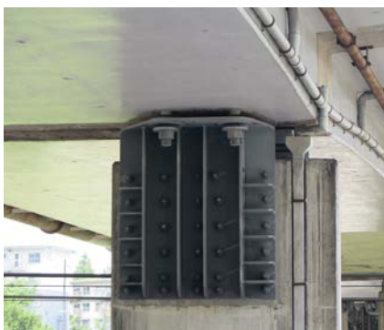
応用型（PC 箱桁設置）
