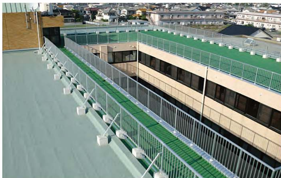
EP-H101 / EP-R2201工法
