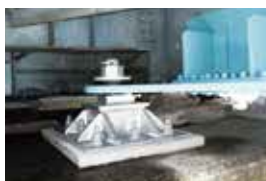
応用型（鉄桁橋羽根連結板－鋼製架台）
