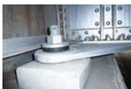
基本型（羽根連結－根巻コンクリート）
