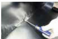
接合部チェック (ドライバー試験)
