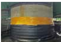
橋脚周り処理
