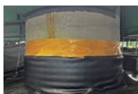
橋脚周り処理
