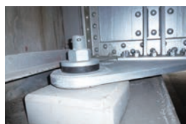
基本型（羽根連結—根巻コンクリート）
