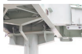
連結型（横断歩道橋、落橋防止）
