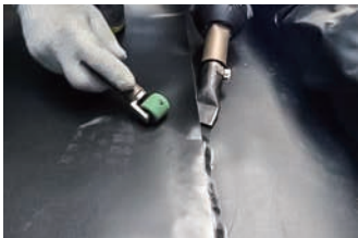
ライスターと転圧ローラーによる熱溶着作業
