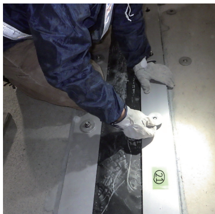
⑤継手設置工
