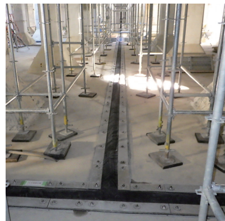
⑥施工完了
