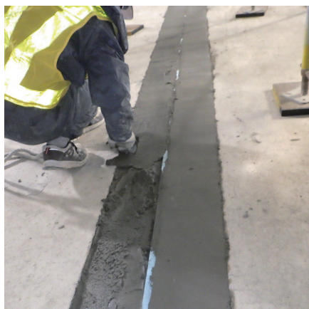
②モルタル工
