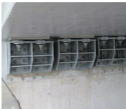
桁下型(鋼製架台2本設置)
