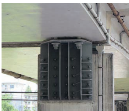
応用型(PC 箱桁設置)
