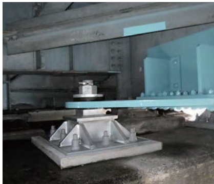
応用型(鋸桁橋羽根連結板-鋼製架台)
