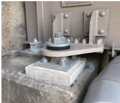
応用型(羽根連結板-PL架台)
