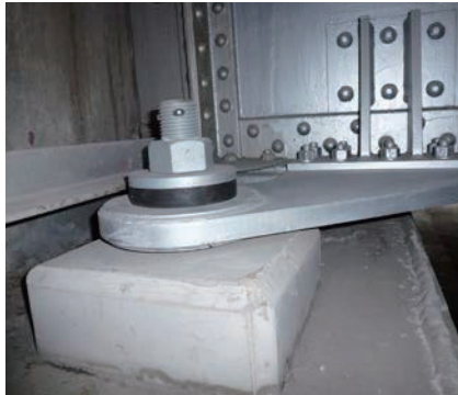
基本型(羽根連結-根巻コンクリート)
