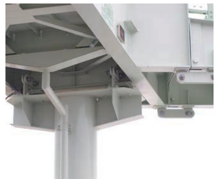
連結型(横断歩道橋、落橋防止)
