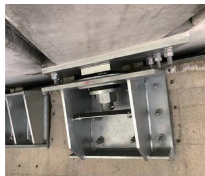
桁下型(PC 水口-桁設置)
