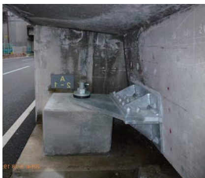
基本型(RC 中空側面設置)
