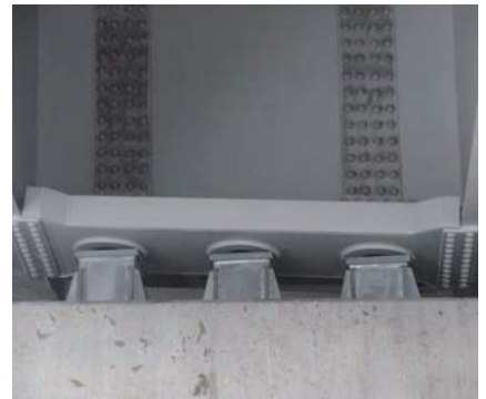
応用型(横梁-鋼製架台)
