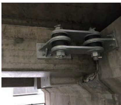
連結型(RC 桁-変位制限構造)
