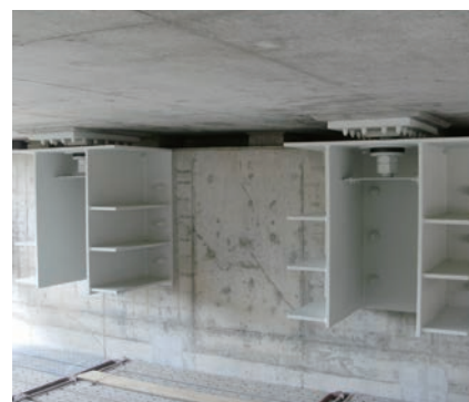
桁下型(Al-Mg溶射、Wナット仕様)
