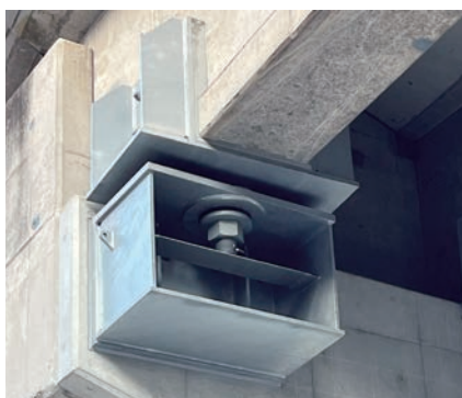
桁下型(RC-T桁設置)
