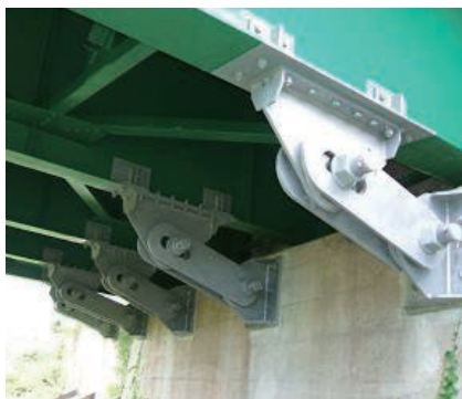
連結型(上部-下部連結、落橋防止)
