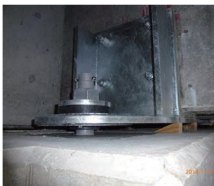
基本型(RC-T桁 縁端拡幅部設置)
