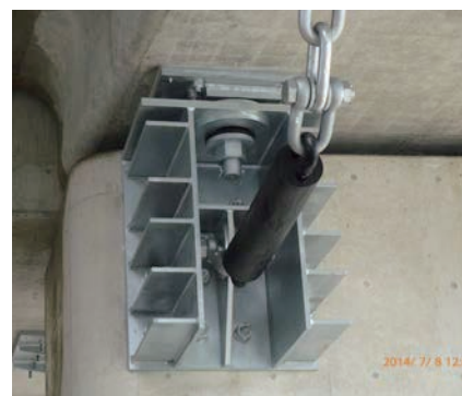
桁下型(RC 中空床版橋-落橋防止構造兼用)
