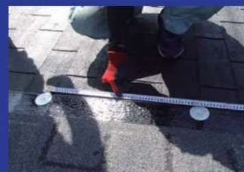
Step5 シート端部ディスク板設置 (ピッチ500mm以下)
